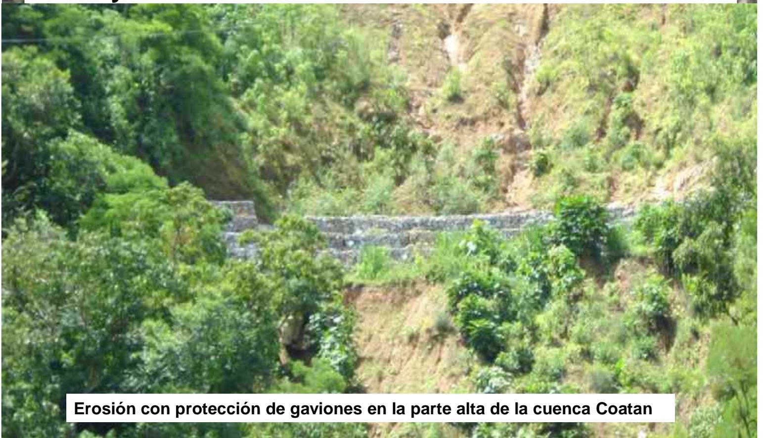
**Erosión con protección de gaviones en la parte alta de la cuenca Coatan**
